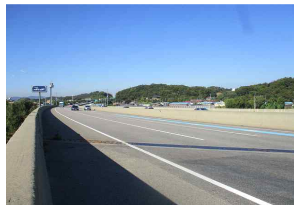
월문3교(양양) 상부 전경
